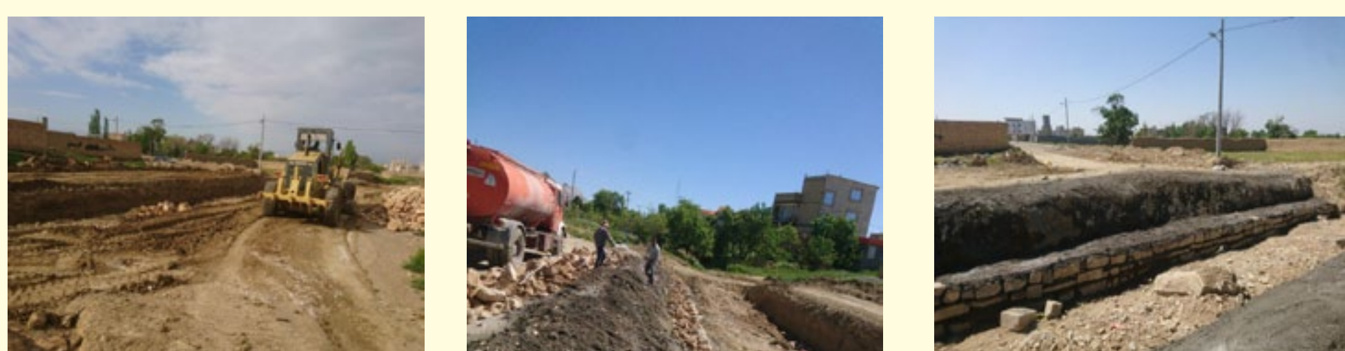
مناسب سازی پل کوی امید: ۴۵ مترطول
