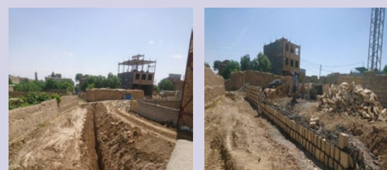
اجرای دیوار ساحلی کوی صداقت: ۵۰ مترطول
