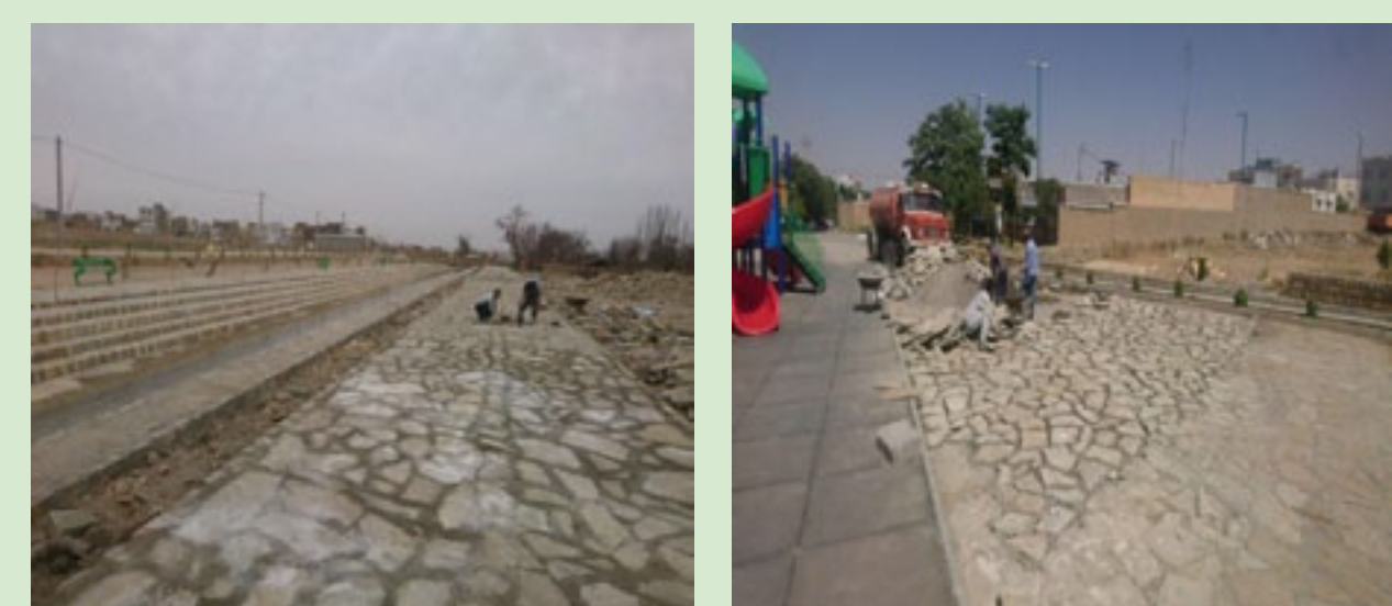
اجرای سنگ کف و مالون در پارک های سطح شهر
