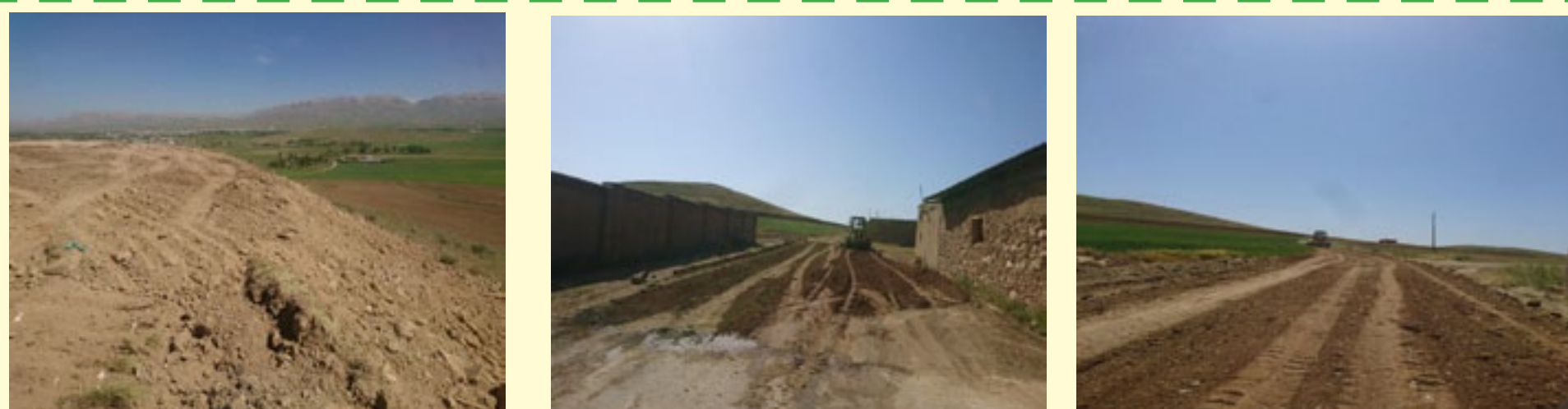
پروژه در دست اقدام: آغاز عملیات پروژه بام کمیجان (زیرسازی اولیه)
